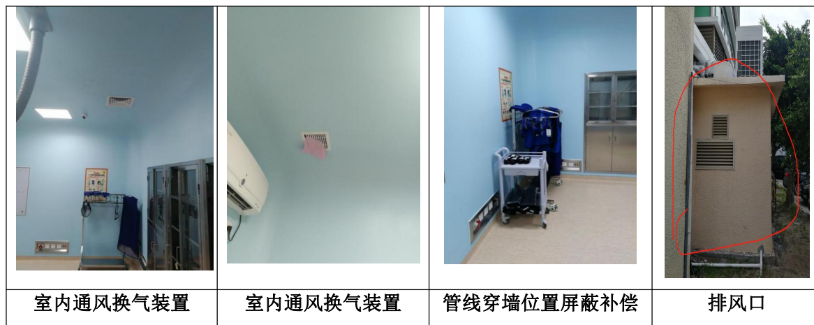
图 3-6 通风与管线孔的辐射屏蔽
