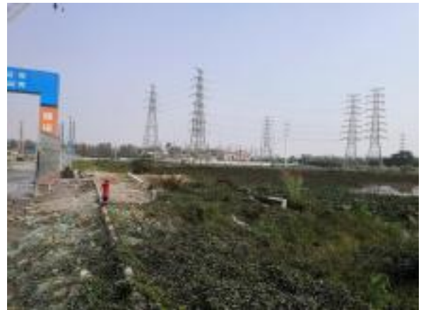
项目场地南面变电站及空地
