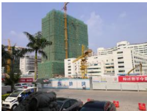
外科大楼南面医技楼
