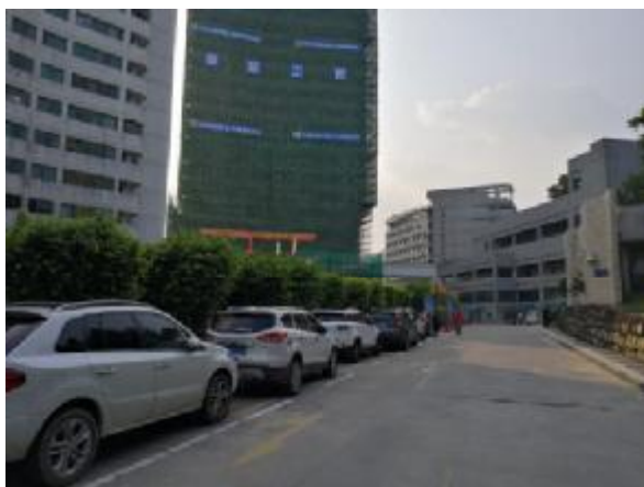
外科大楼东面过道
