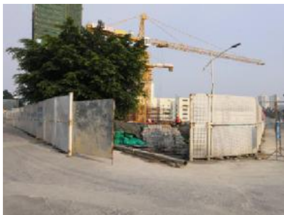
外科大楼西面
