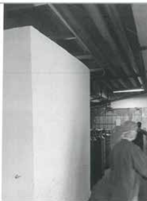
拟建场所北侧-通道
