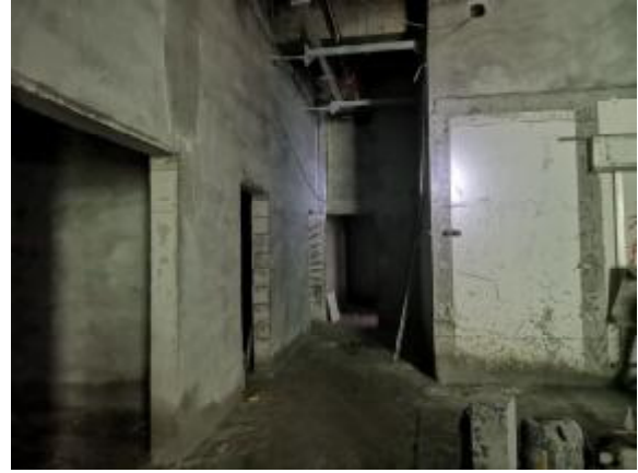
直线加速器机房东面
