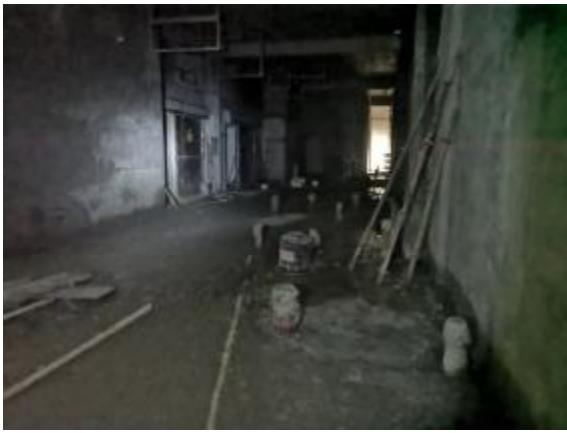
直线加速器机房北面
